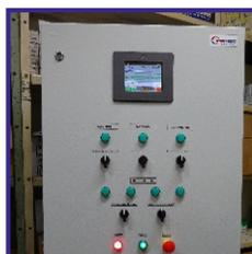
**Силовой шкаф.** К силовому электрошкафу подключены все исполнительные механизмы, ответственные за ведение технологического процесса. Переключатели на передней панели шкафа позволяют переходить на ручное управление всем оборудованием сушильной камеры (например, при проведении регламентных и ремонтных работ).
